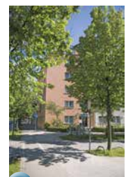
11 a) Haus an der Knorrstraße Knorrstraße 26 80807 München
