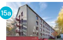
15a) Haus an der Pistorinistraße Servicestelle für Arbeit & Beschäftigung Pistorinistraße 30 81543 München
